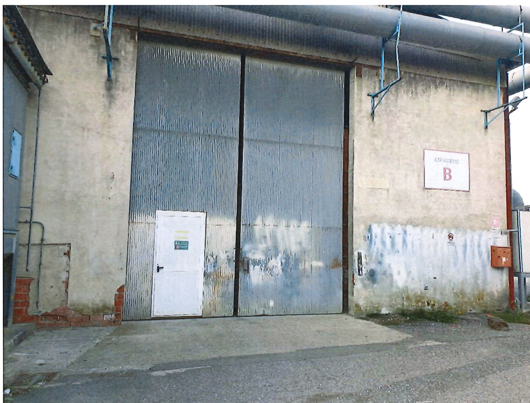
Foto 6 – Prospetto Capannone B
