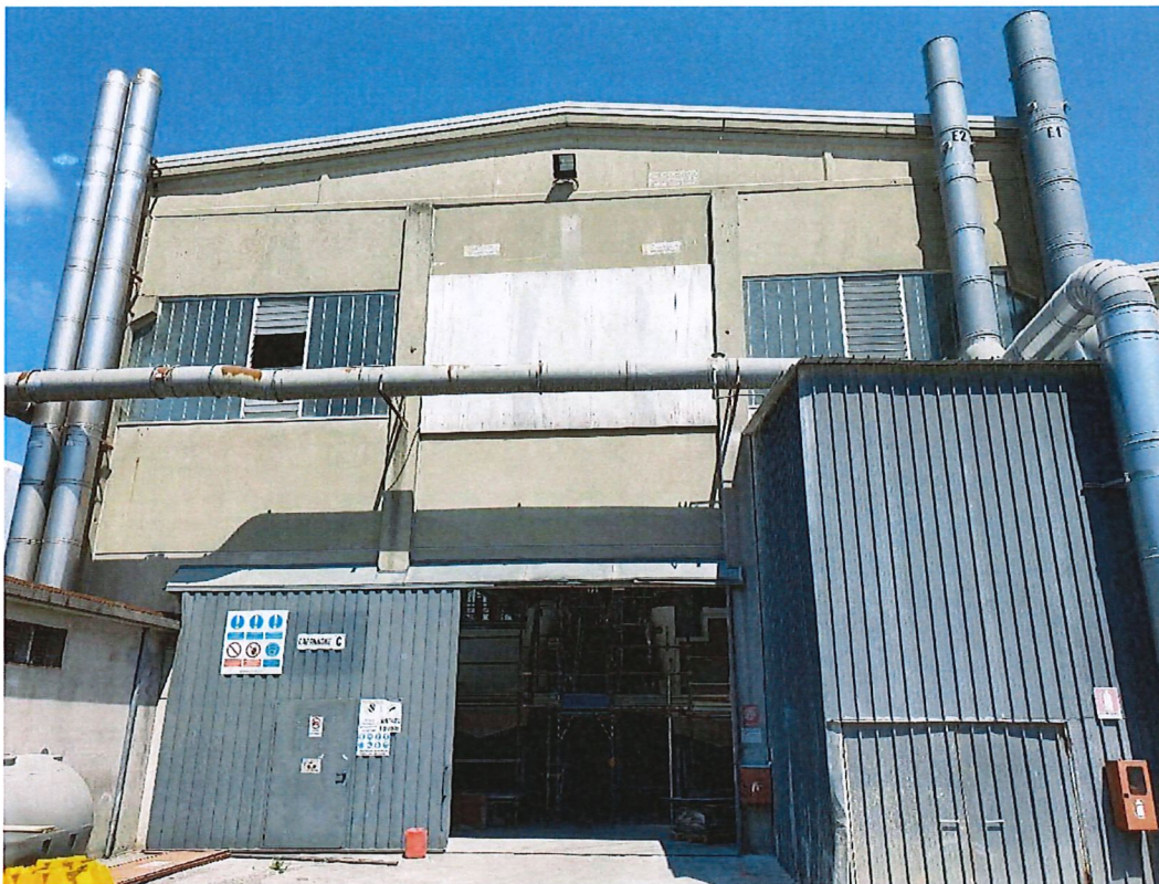
Foto 3 – Prospetto capannone C
