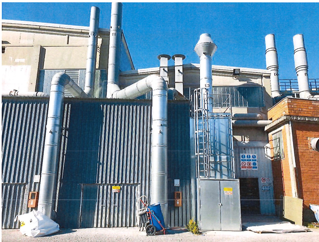
Foto 5 – Prospetto capannone E e adiacenti impianti
