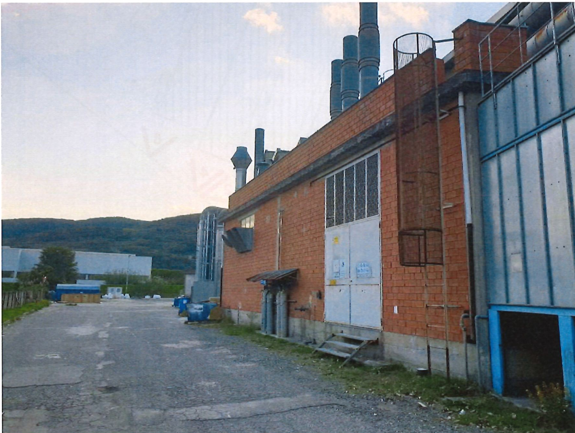
Foto 2 – Locale tecnico con tamponamento in mattoni
