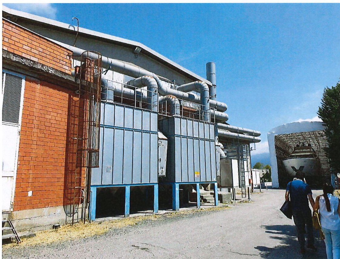
Foto 4 – Prospetto capannone A e B e adiacenti impianti
